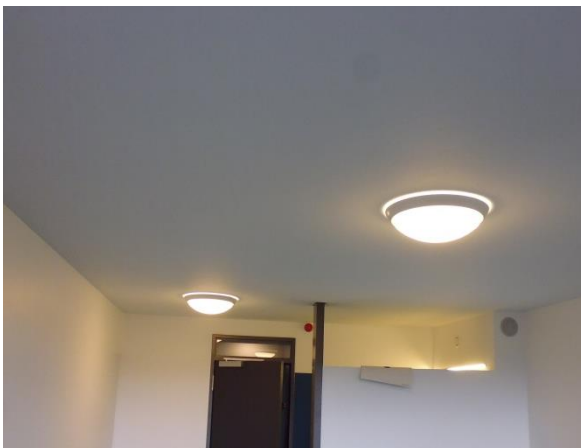
Neue LED-Beleuchtung in Bettenzimmern
