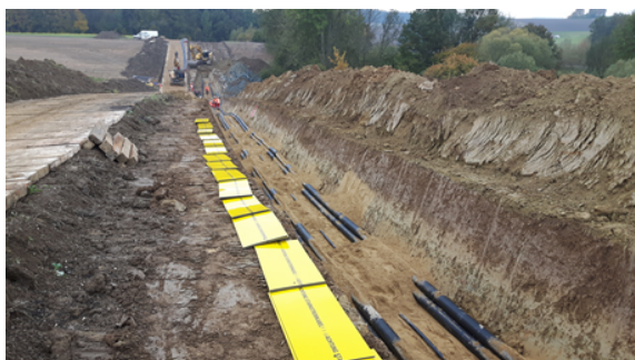
Abb. 1: Wiederverwendung von Bodenaushub beim Verlegen von Erdkabeln. Hier wurde der Oberboden (links) vorbildlich vom Unterboden (rechts) getrennt und im Anschluss wieder lagenweise eingebaut.
