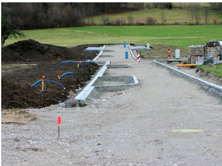
Abb. 3: In Straßenbaumaßnahmen können auch bestimmte Bodenfraktionen mit höheren Schadstoffbelastungen (i. d. R. bis BM-F3) eingesetzt werden.
