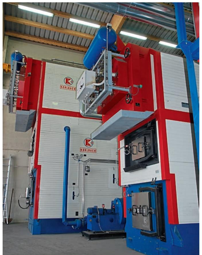
Mit zwei Biomassekesseln mit einer Leistung von 600 und 1.500 kW Leistung versorgt das Heizwerk in der Kreisstadt Freyung 90 Abnehmer vom Privathaushalt bis zum Kreis-Krankenhaus. Die Flammtemperatur im Biomassekessel beträgt circa 800 Grad. Die Feuerraum-Kamera dient dem Heizwart zur Ferndiagnose.
