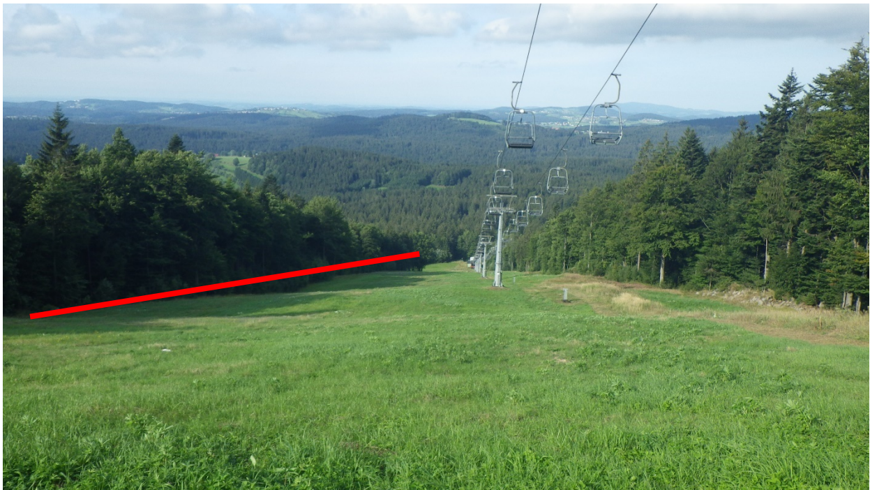
Abbildung 6: Künftiger Verlauf der 6er-Sesselbahn Almbergbahn. Die bestehende Anlage (rechts im Bild) wird abgebrochen.
