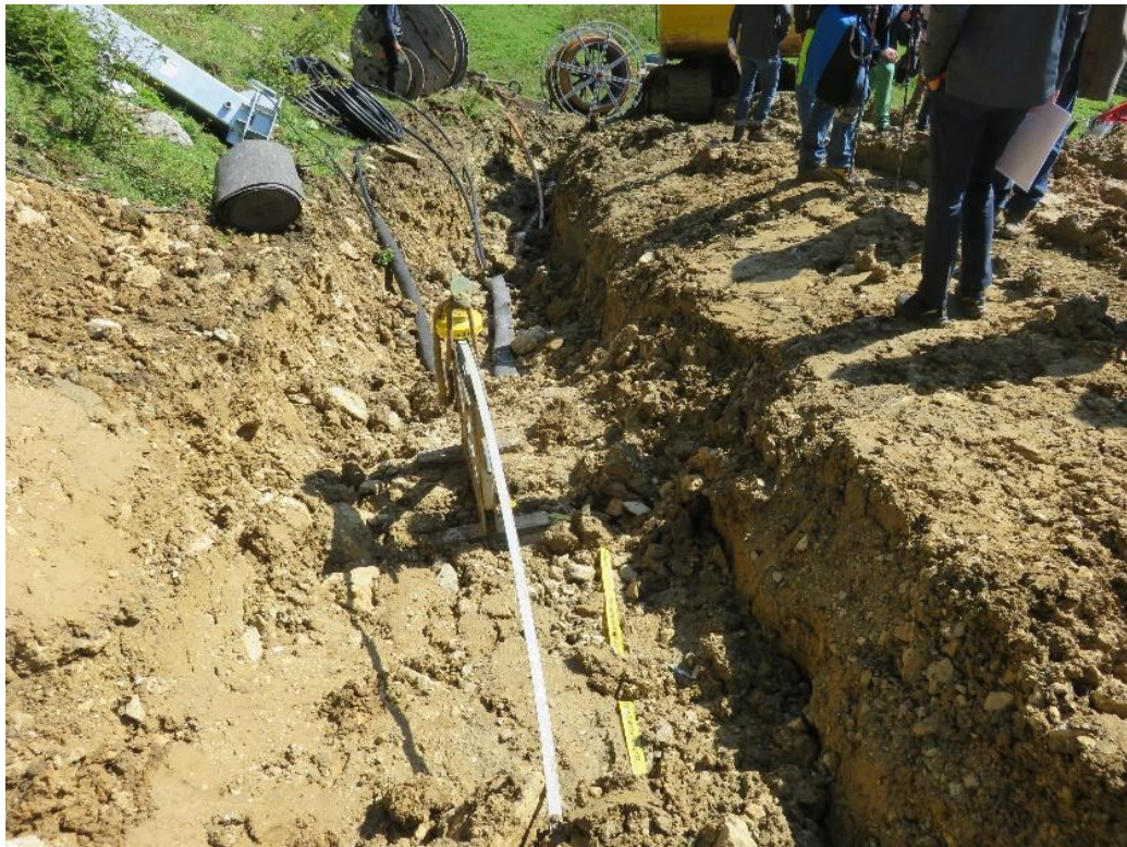
Abb. 6: Beispielhafte Bauweise eines Kabelgrabens (abschnittsweises Abrollen der Kabeltrommeln) und sichtbarem Kabelschutzband (gelb).
