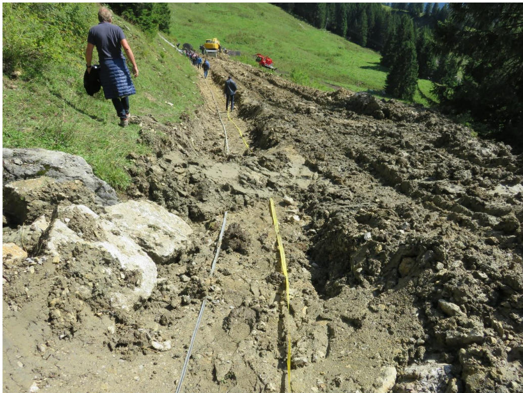
Abb. 7: Beispielhafte Ausführung eines Lehmschlags (zentral im Bild) und oben sichtbares Kabelschutzband (gelb).
