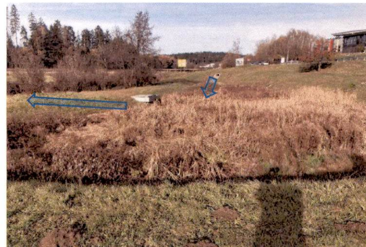
E 03 SKU Reismühle, Einleitung über ein offenes RRB mit Schilfbewuchs in den Grüberbach
