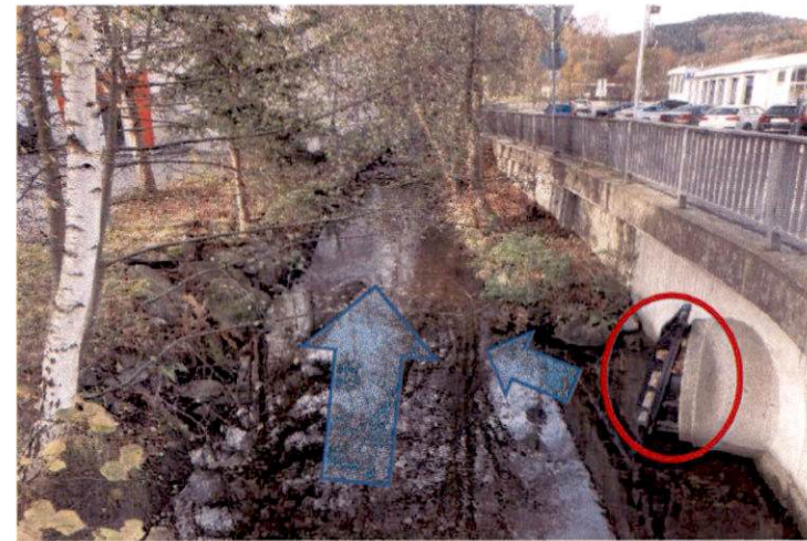
E 09 RÜB Bahnhofstraße, Einleitung in den Mühlkanal der kleinen Ohe
