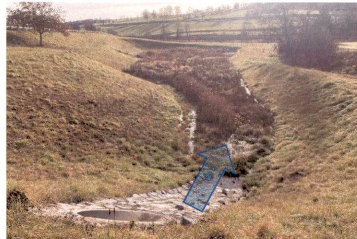
E 03 SKU Reismühle, Einleitung über ein offenes RRB mit Schilfbewuchs in den Grüberbach
