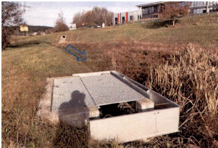
E 03 SKU Reismühle, Einleitung über ein offenes RRB mit Schilfbewuchs in den Grüberbach
