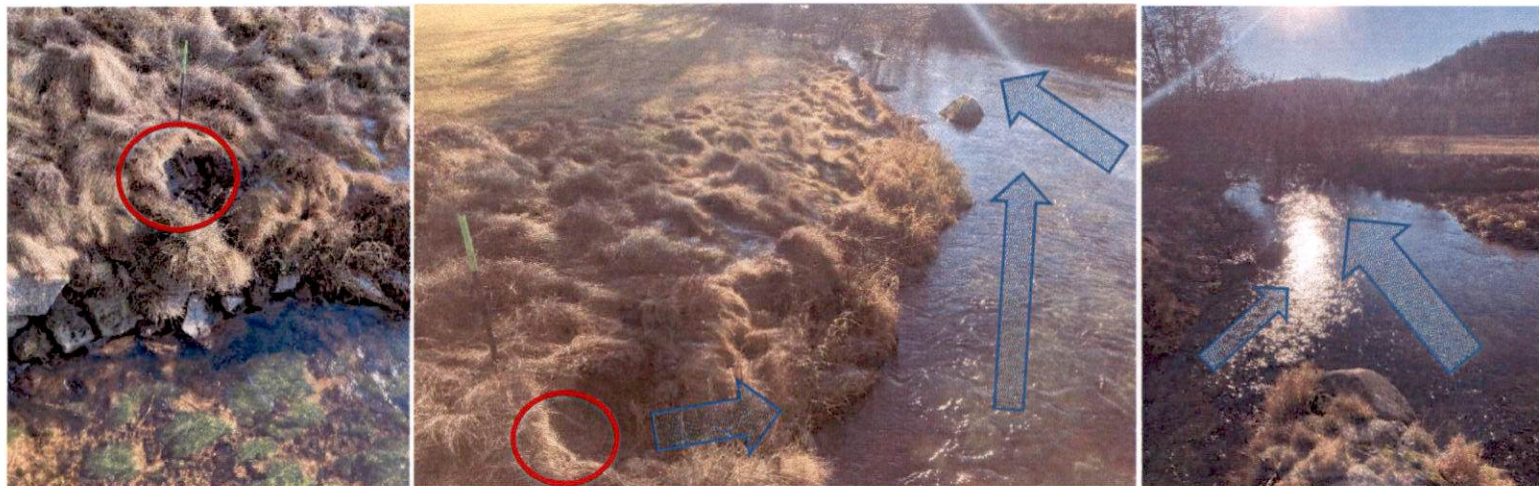
E 4 RÜB Ettlühle, Einleitung in die Ilz
