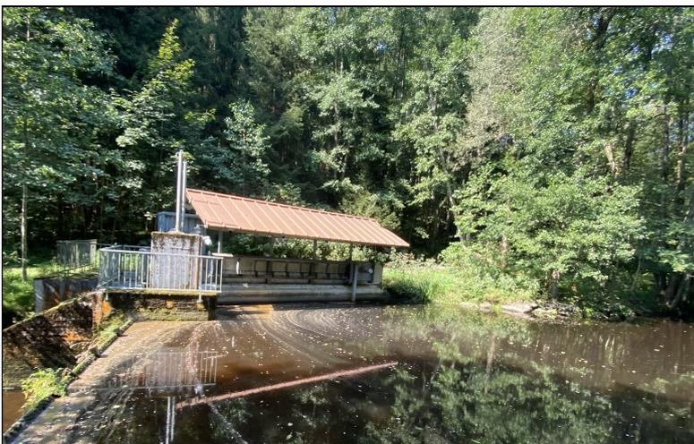
Abbildung 1: Einlaufbauwerk inkl. Stauklappe, Grundschütz und Querrechenanlage (Oberwasser)
