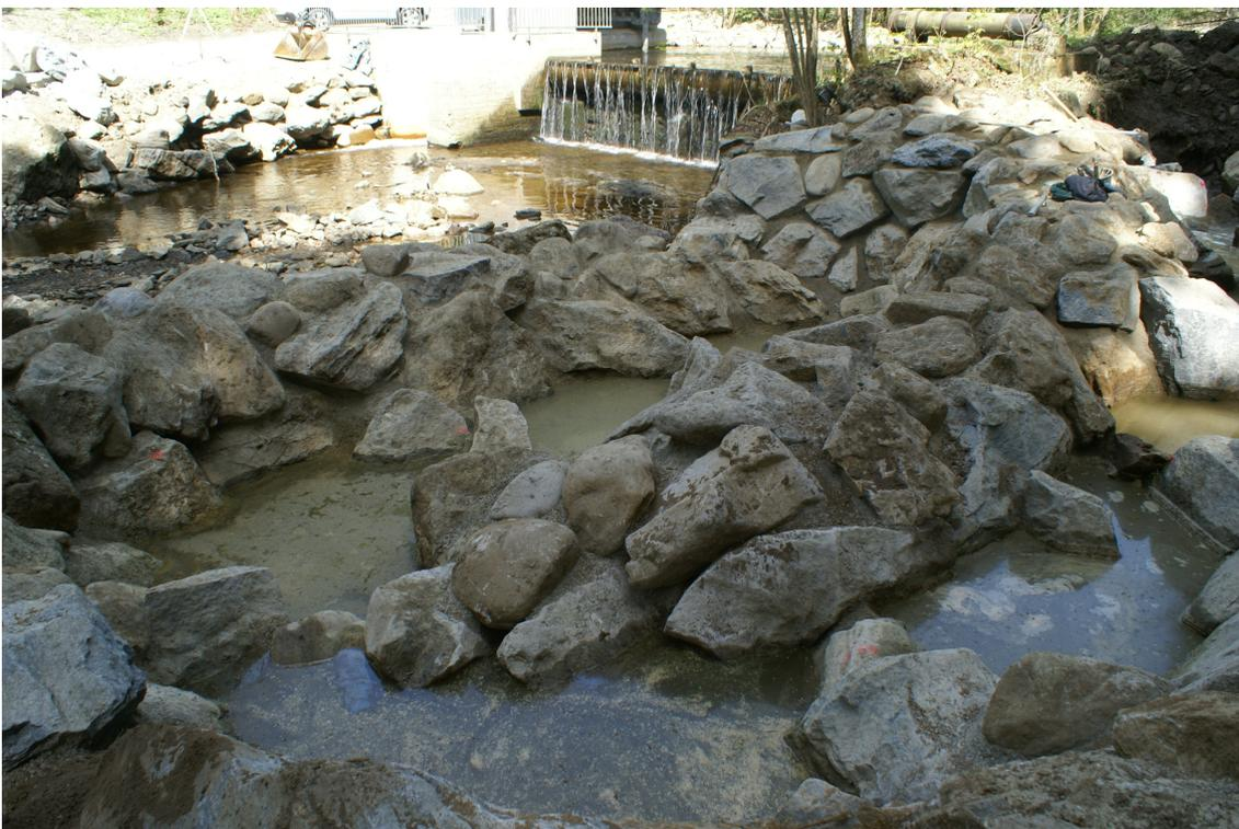
Die verbleibenden 25 l/s werden über die bestehende Grundschütztafel mit obenliegender Klappe abgegeben. Dafür wird eine oberflächennahe Öffnung hergestellt, welche in Form eines freien Überfallstrahls eine konstante Wassermenge von 25 l/s abgibt (hydraulische Berechnung siehe Anlage 7.3)
