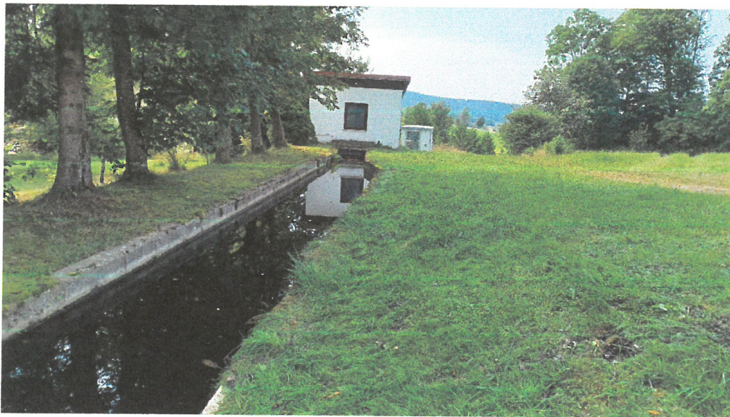
Oberwasserkanal und Einlaufbauwerk
