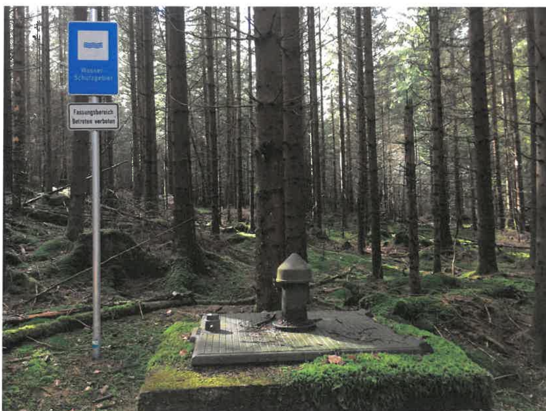
Abbildung 2: Blick auf den oberirdischen Abschluss der Quellfassung
